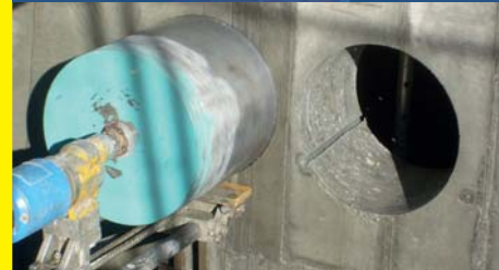
Diamantbohr- und Schneidearbeiten
