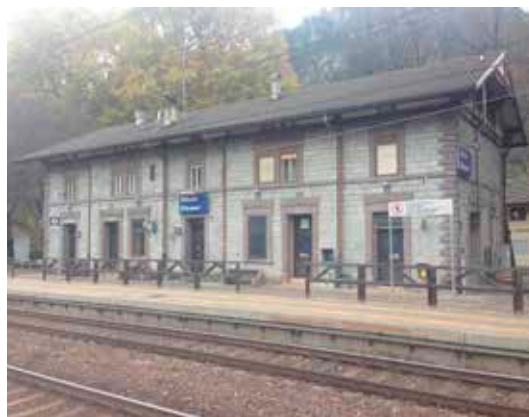
Zugbahnhof Klausen – La stazione dei treni di Chiusa
