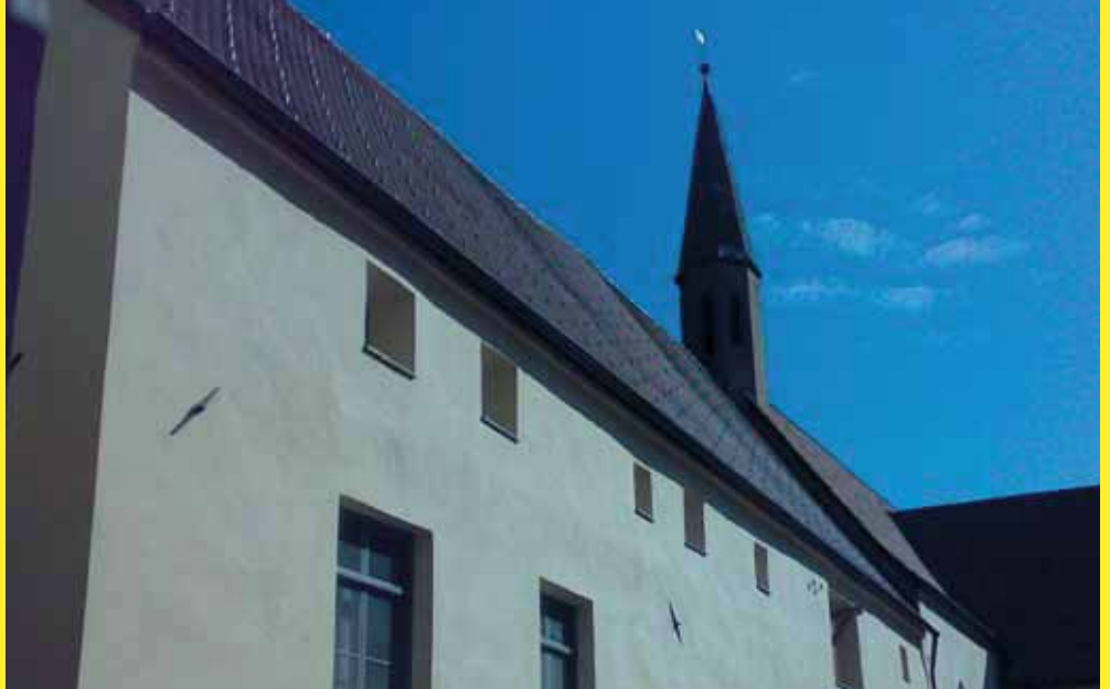
Das Apostelhaus erstrahlt in neuem Glanz.
