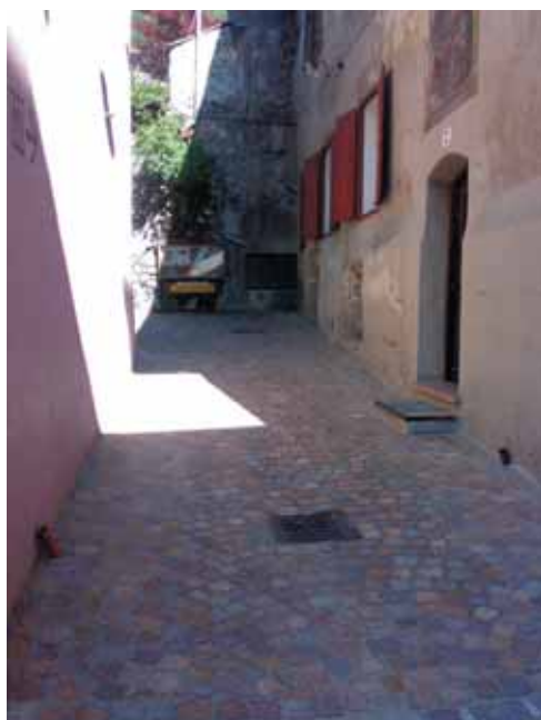
La nuova pavimentazione: Salita Sabiona
