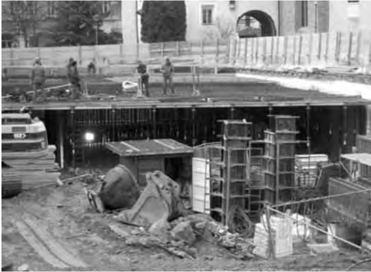
Bauarbeiten an der Tiefgarage, Anfang Dezember 2006 Lavori in Piazza mercato, dicembre 2006
