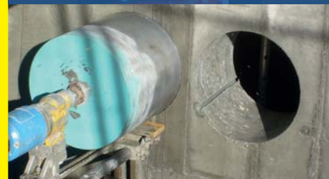
Diamantbohr- und Schneidearbeiten
