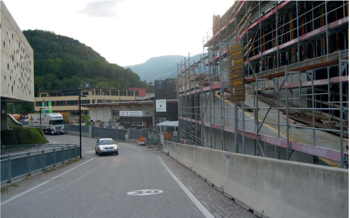
In der Gewerbezone Spitalwiese entstehen gerade einige Neuansiedlungen.
