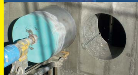
Diamantbohr- und Schneidearbeiten
